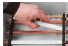
Isoleringskappe for samleskinner
