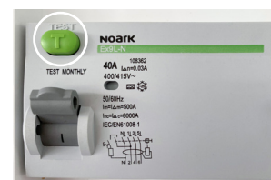
Fejlstrømsafbryderen testes 1 gang årligt, ved at trykke kortvarigt på den ovale grønne testknop "T".
